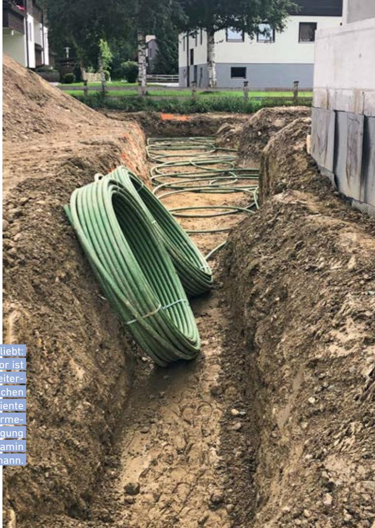
Vor allem im Neubau beliebt: Der Ringgrabenkollektor ist die platzsparende Weiterentwicklung der klassischen Erdwärme – und eine effiziente Alternative zur Luftwärmepumpe. Am Foto: die Verlegung am Grundstück von Benjamin Schludermann.
